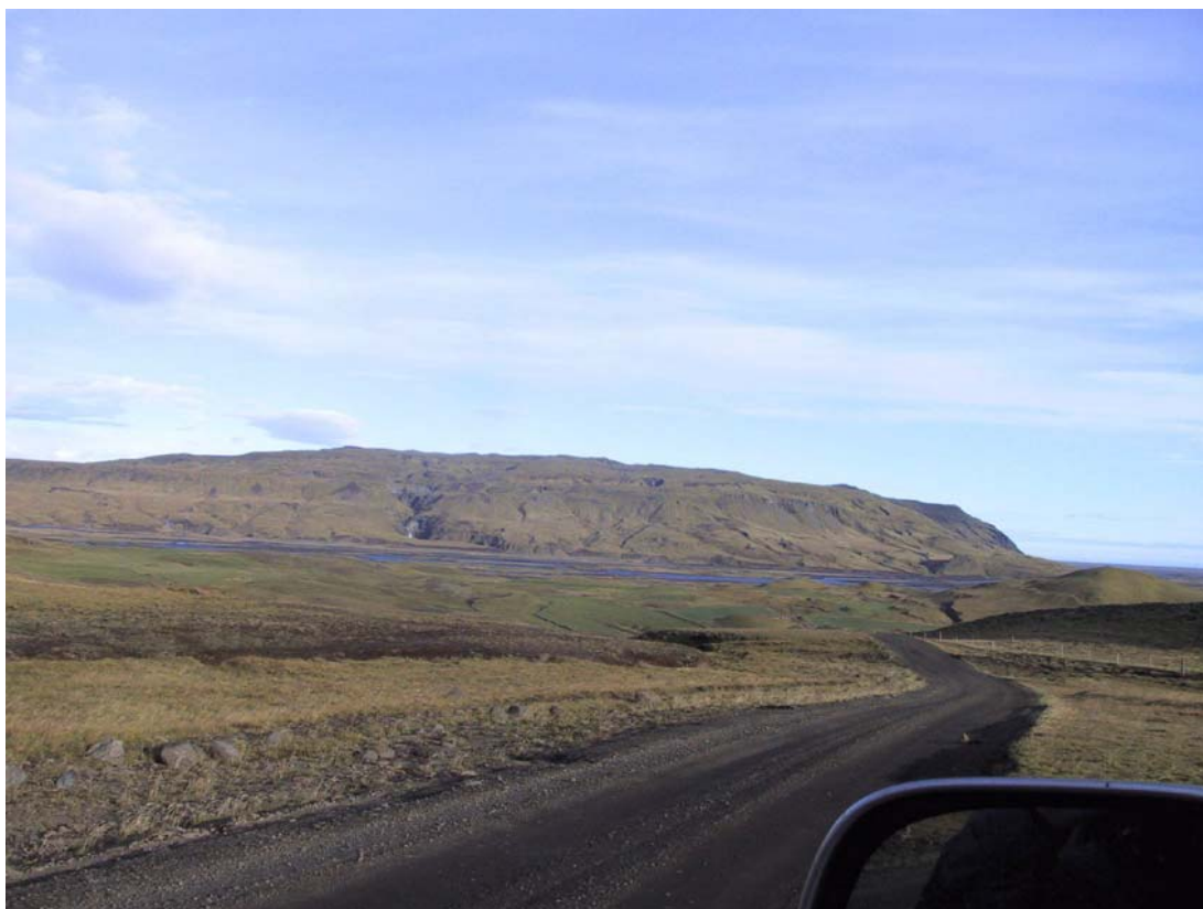
Óuppbyggður malarvegur í Skaftártungum
